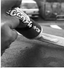
①感圧コードセンサ用固定レール (FKS-L6) にボンド「サイレックス」を塗布。(40～50cm毎に10cm程)
